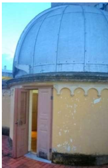
Figura 8 - Detalhe da cúpula da Luneta Equatorial instalado no terraço da edificação
