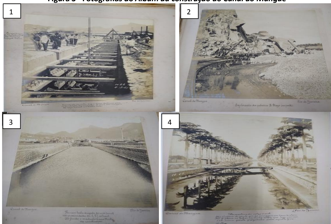
Figura 3 - Fotografias do Álbum da construção do Canal do Mangue
