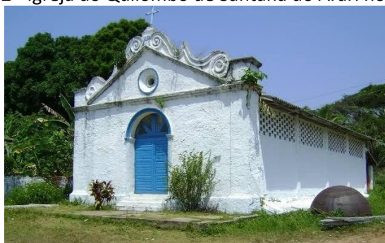
Figura 2 - Igreja do Quilombo de Santana do Arari no Estado do Pará.
